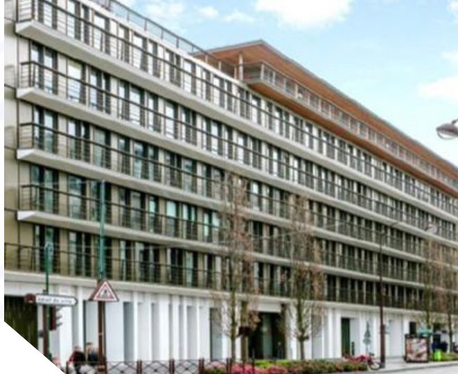
Achille Peretti, Neuilly sur Seine (immeuble de bureaux détenu par la SCI)
