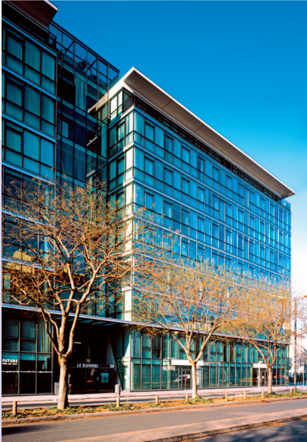
"Le Bonnel" • 20, rue de la Villette Lyon (69)
